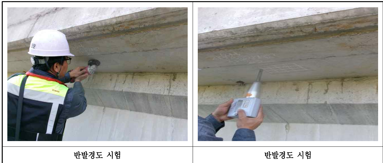
【사진 43.4.2】 반발경도시험 현장사진
