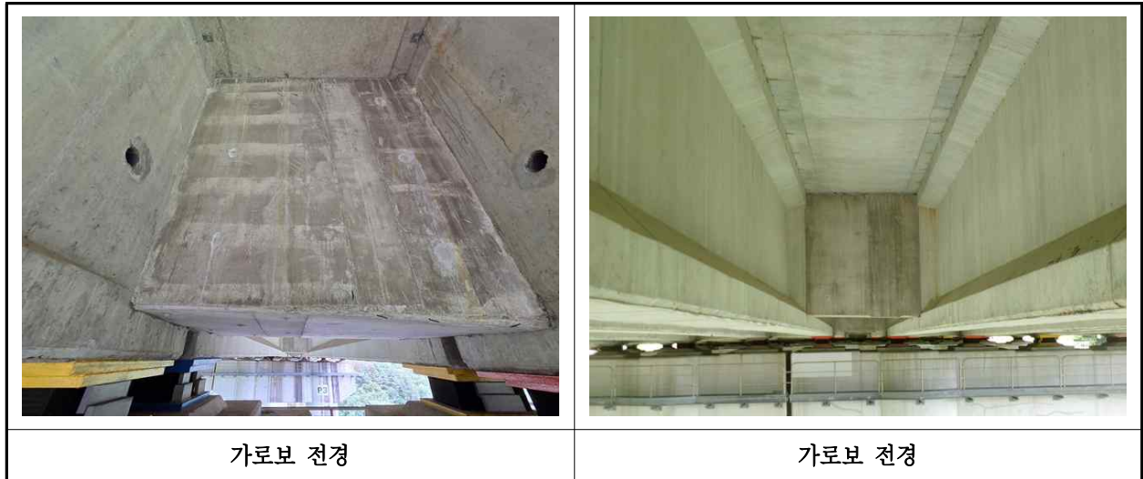
【사진 43.3.6】 가로보 전경
