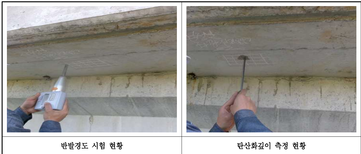
【사진 43.4.1】 콘크리트 내구성조사 현황
