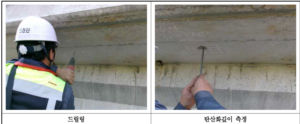
【사진 43.4.3】 탄산화 깊이 측정 현장사진
