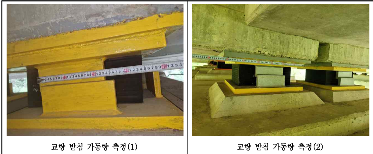
【사진 43.3.16】 교량받침 이동량 측정
