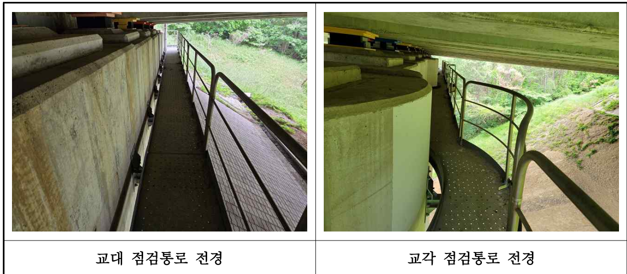
【사진 43.3.26】 교량 점검시설 전경
