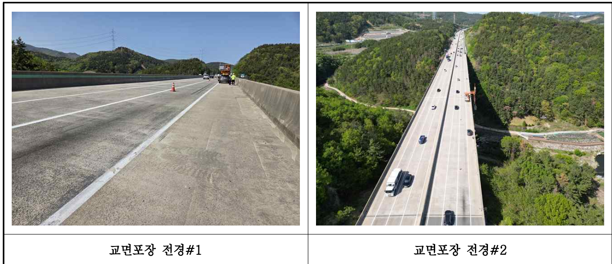
【사진 43.3.20】 교면포장 전경
