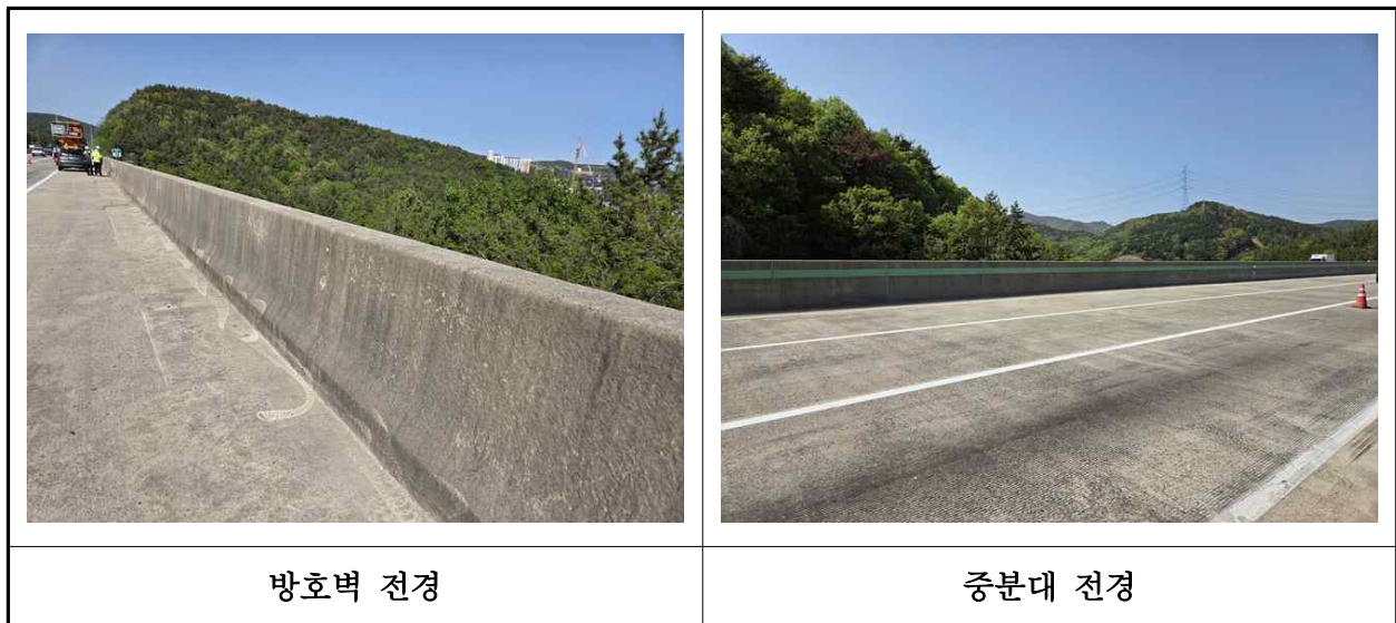
【사진 43.3.24】 방호벽 및 중분대 전경
