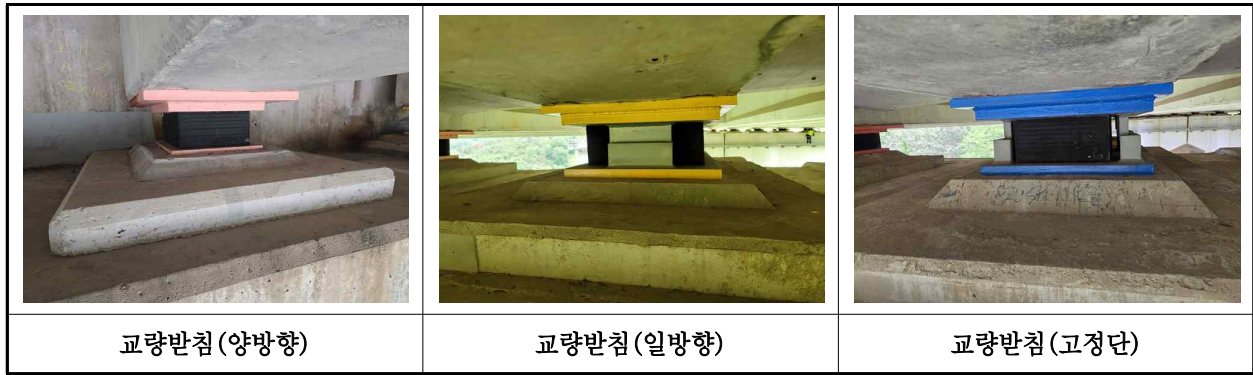
【사진 43.3.13】 교량받침 전경
