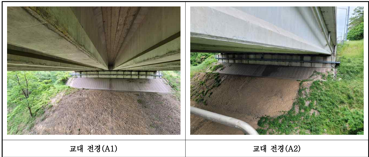
【사진 43.3.8】 교대 전경
