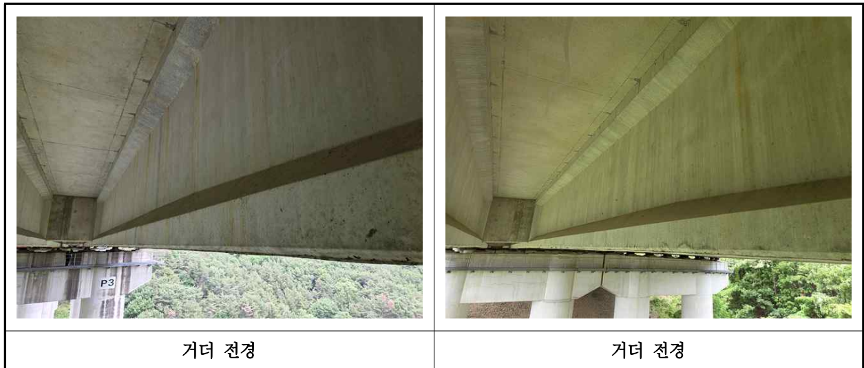
【사진 43.3.4】 거더 전경
