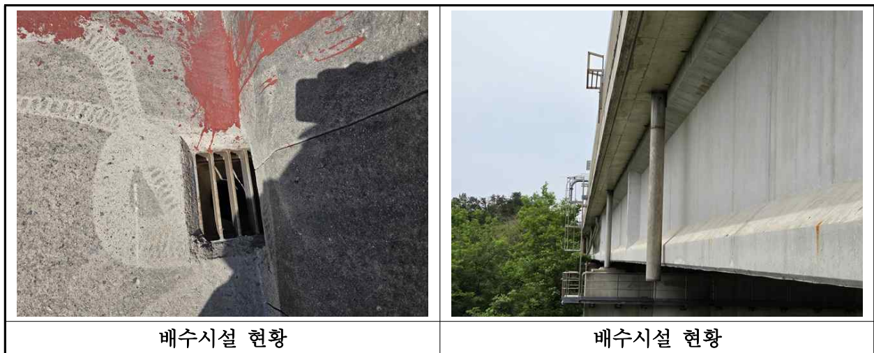
【사진 43.3.22】 배수시설 전경
