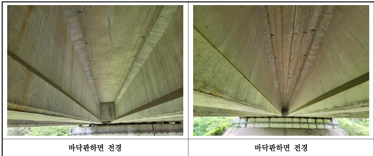
【사진 43.3.2】 바닥판하면 전경
